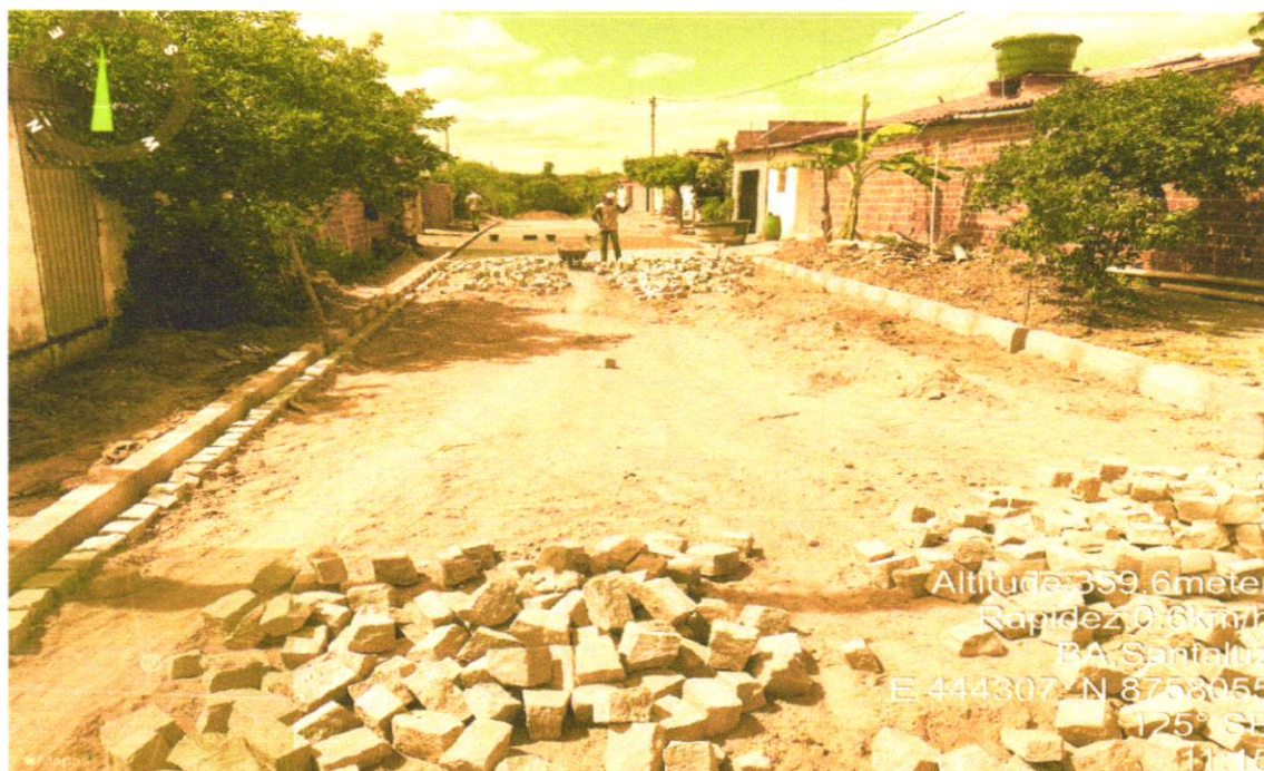
FOTO 01 EXECUÇÃO DE MEIO E PAVIMENTAÇÃO RUA CHICO MENDES
